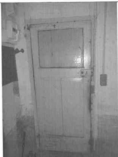
Illustration de la porte et bâti de porte du garage en zone A
