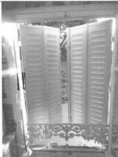
Illustration de la fenêtre, du garde-corps et du volet de la pièce 3 en zone B
