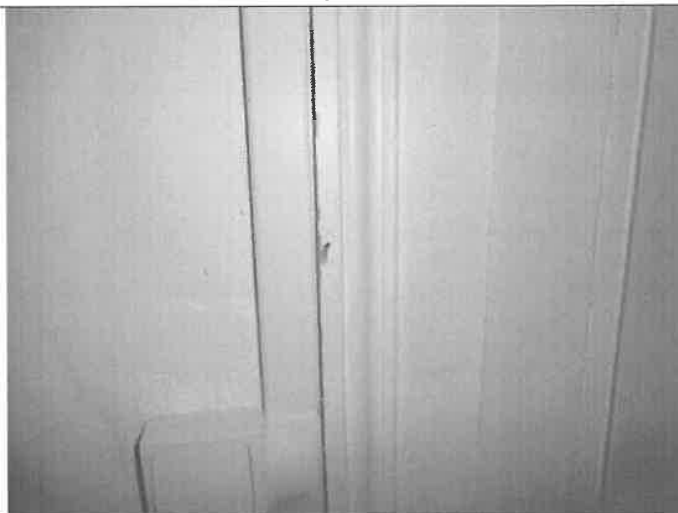
Illustration de la porte et bâti de porte de la pièce 5 en zone B
