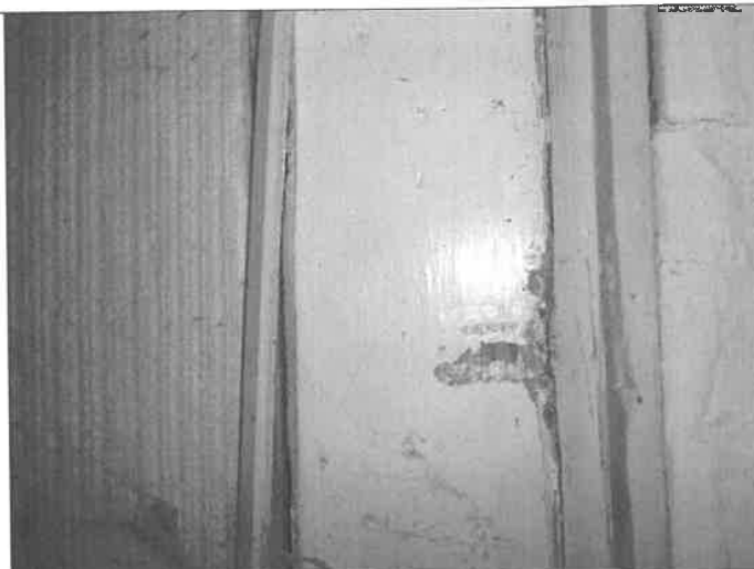
Illustration de la porte et bâti de porte du garage en zone A
