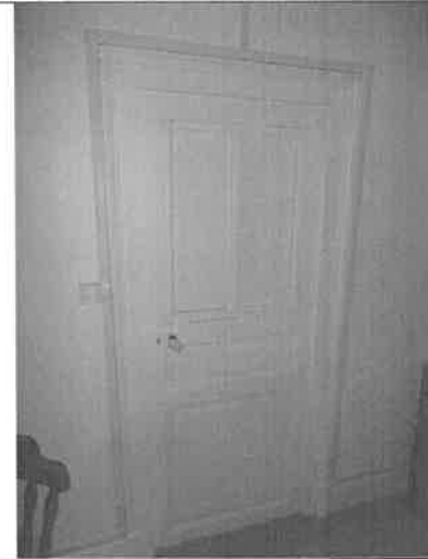
Illustration de la porte et bâti de porte de la pièce 5 en zone B
