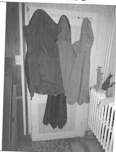
Illustration de la porte et bâti de porte de la pièce 1 en zone A
